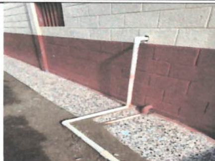
Foto 2: RED DE REPACIÓN DE DRENAJES Y RED DE AGUA POTABLE Sustitución de tuberías PVC para redes hidráulicas de drenaje, adherencias entre cortes, uniones de tubería y accesorios con pegamento PVC
