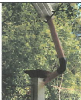
Foto 5: CANALES Y BAJADAS DE AGUA PLUVIAL sustitución de bajantes para evacuación de aguas pluviales anclada por medio de abrazaderas y tornillos
