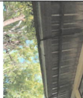
Foto 4: CANALES Y BAJADAS DE AGUA PLUVIAL Sustitución de canales para evacuación de aguas pluviales Material: lamina galvanizada Tipo: Ilsa, Anclaje: canal sostenido por pescantes metálicos
