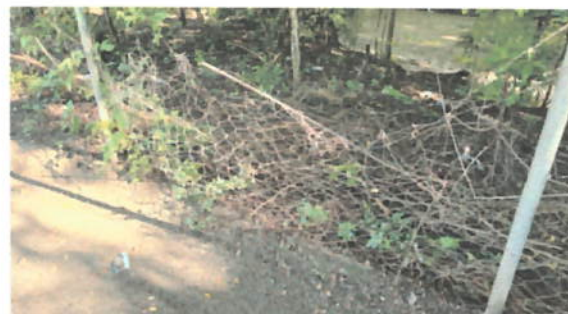
Foto 2: CERCO O MURO PERIMETRAL Sustitución malla de acero galvanizado en perímetro del establecimiento, con instalación fija y tensa, anclajes metálicos en intervalos regulares
