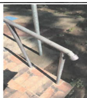
Foto 6: MANTENIMIENTO DE BARANDAS Sustitución de barandales metálicos, incluyendo fijaciones, pintura y soldaduras.
