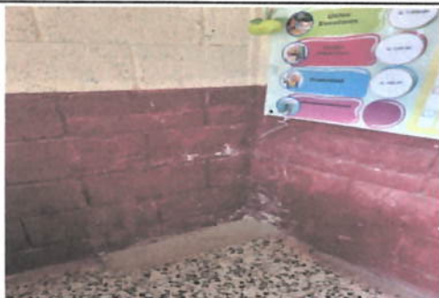
Foto 1: PINTURA EN MUROS INTERIOR Y EXTERIOR Preparación de la superficie y aplicación de pintura a dos manos en paredes interiores y exteriores del establecimiento.
